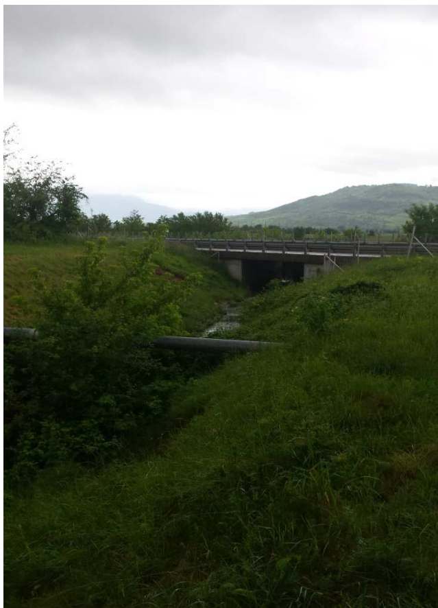
Slika 8: Križanje odvodnika za odvajanje padavinskih vod s kanalizacijo komunalne vode (Matrika ZVO d.o.o., maj 2016)
