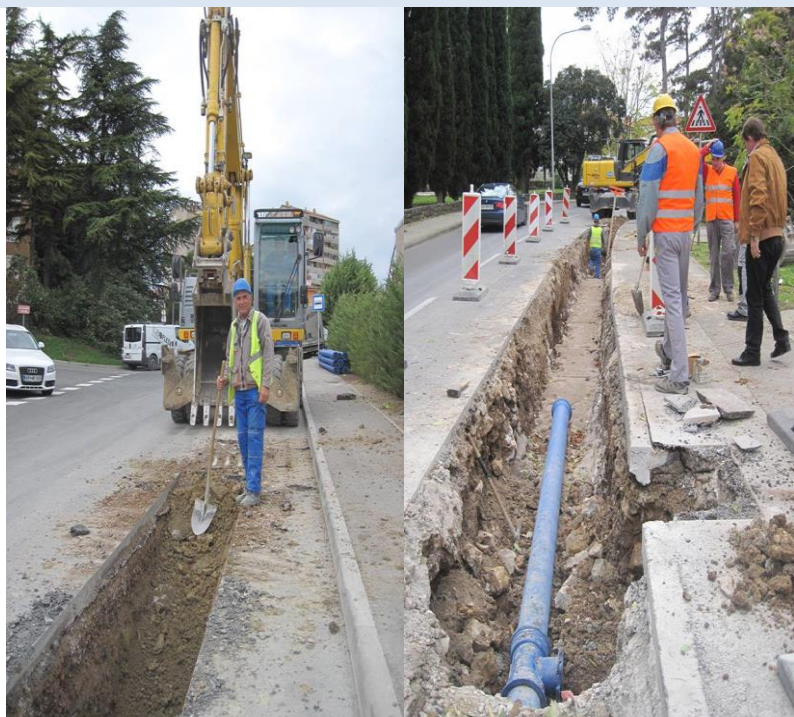
Gradnja na Kraljevi in Dantejevi ulici
