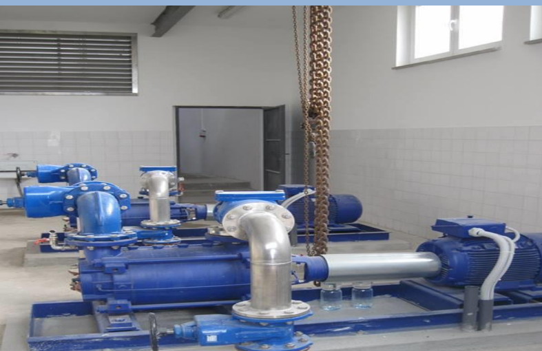
Vodohran Sveti Anton - notranjost
