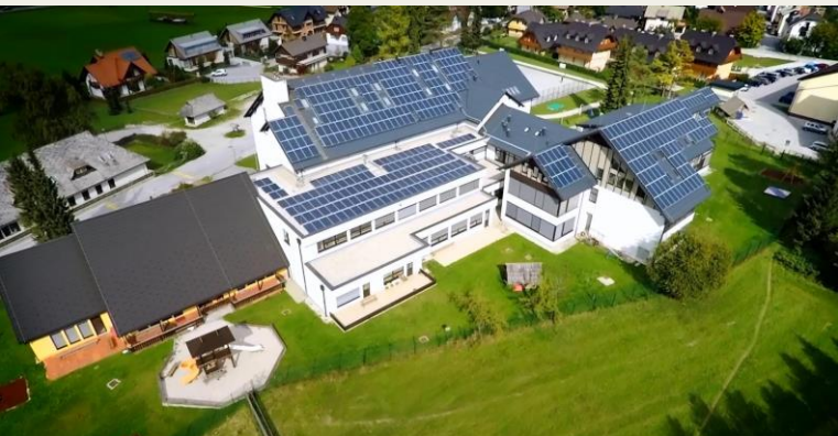
Sončna elektrarna, OŠ Kranjska Gora
